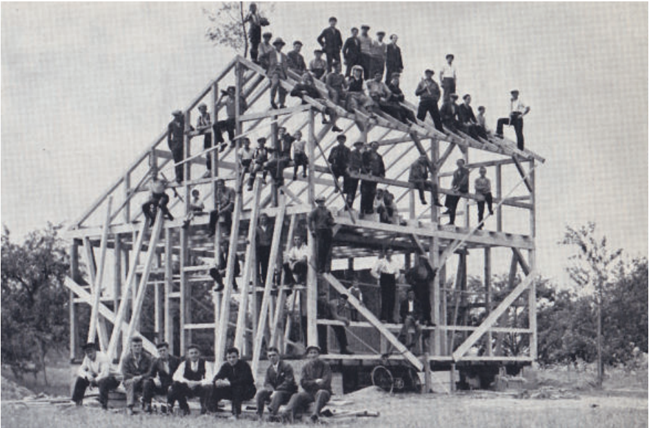
Richtfest am Sportheim des RSV
